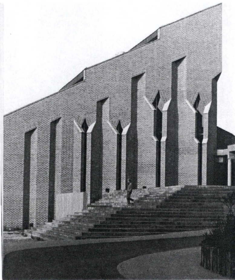
Pignon Est de l'église Saint-François d'Assise (Photo J. COSSE)
