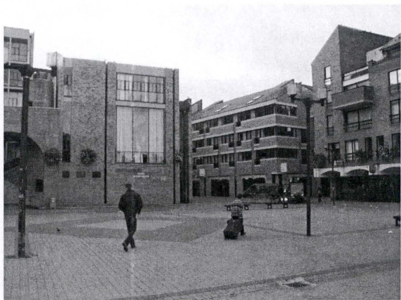
La place de l'Université à Louvain-la-Neuve : à gauche, les Halles. (Photo M.-A. COLLET, septembre 2004)
