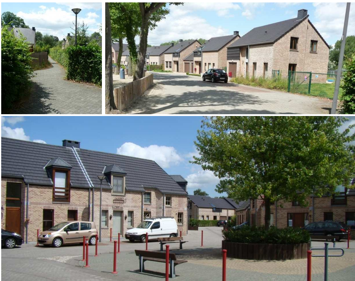
ARQUENNES (Parc de la Cartonnerie) Opération de logements individuels groupés DENSITE : 29 LOG/HA
