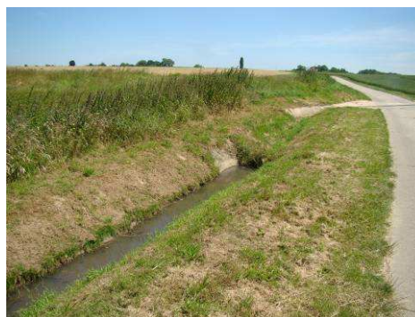
Fossé de canalisation
