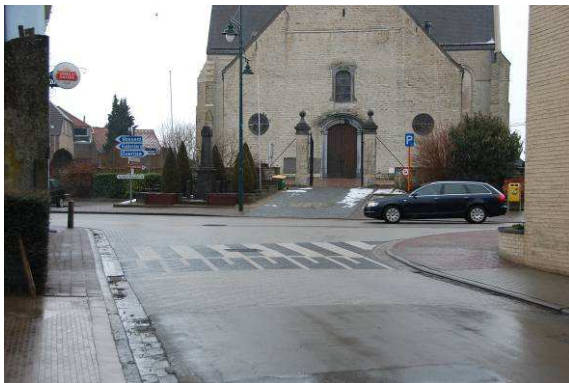
La présence d'un revêtement particulier aux abords de l'église met celle-ci en valeur.
