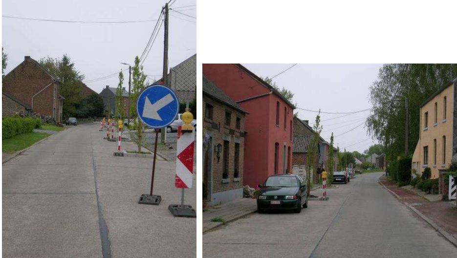
Aménagements à alterner à gauche et à droite de la chaussée (Source : IBSR)
