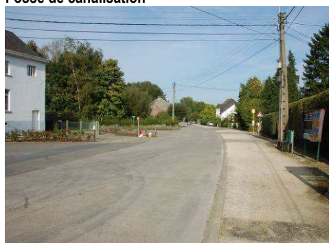
Ry de Corbais canalisé au niveau de la rue Warichet
