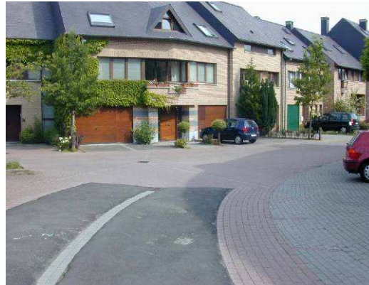
La discontinuité de l'asphalte indique une faible tolérance de la présence de voiture. (Source IBSR)
