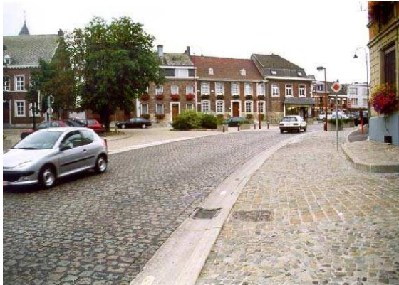
Sur cette voie de déserte, l'ensemble des revêtements étant au même niveau, seuls les filets d'eau délimitent la chaussée. (Source IBSR)
