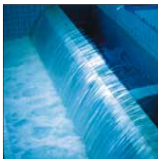
Chute d'eau à la sortie de l'ozonation
