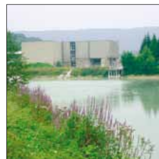
Traitement des boues
