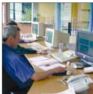
Salle de contrôle
