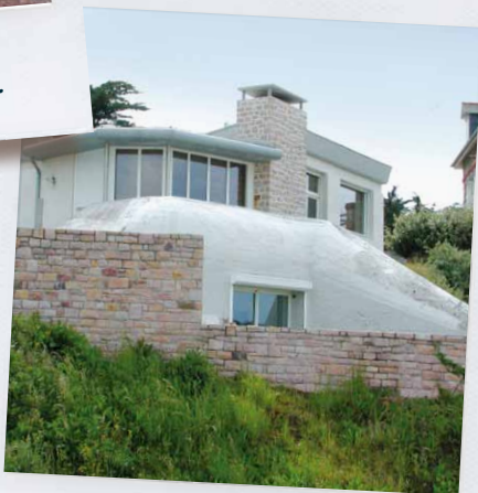
Architecture contemporaine intégrant un blockhaus.
