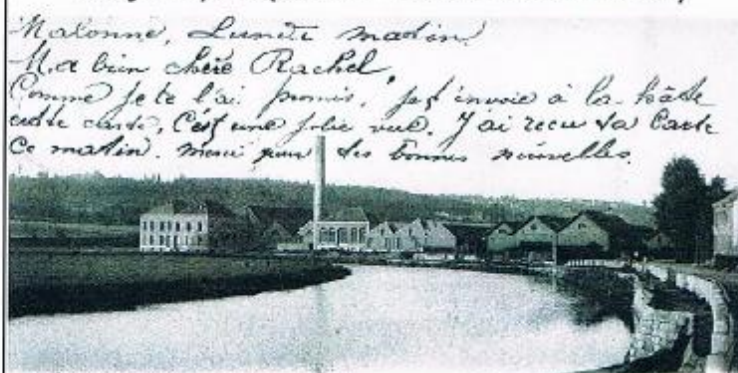
Malonne La Majolique et le Dépôt du Vicinal.
