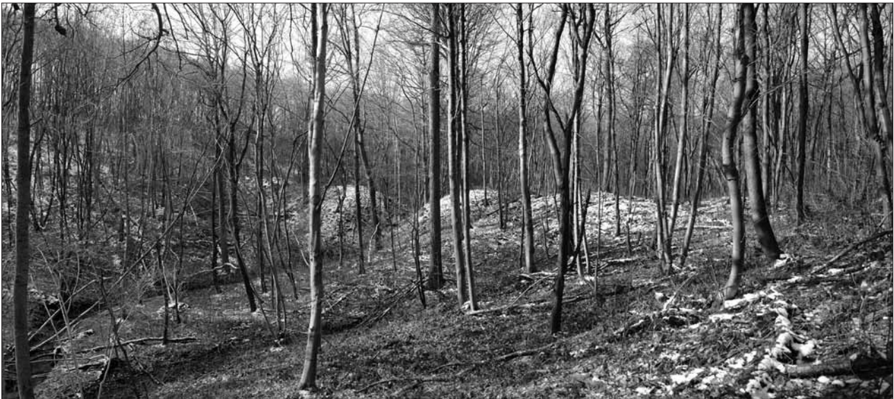
Le barrage en terre dont la rupture médiane est traversée par le ruisseau Goddiarch. Au premier plan, le fossé d'évacuation du trop-plein de la retenue d'eau, rejoignant le ruisseau dans le coin inférieur gauche du cliché. Vue vers le sud.
