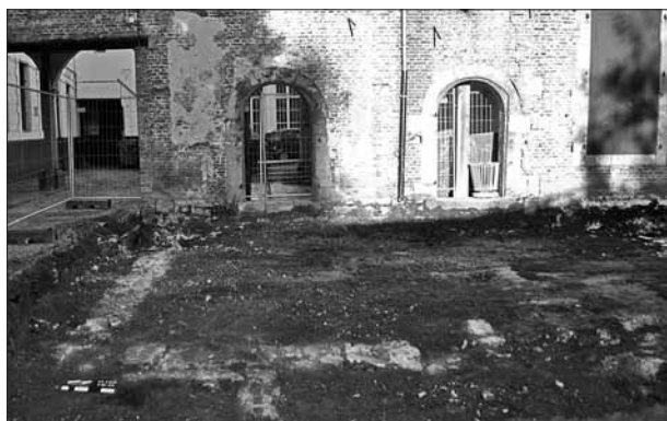
Vue vers le nord-ouest de l'annexe située contre l'aile toscane du n° 20.
