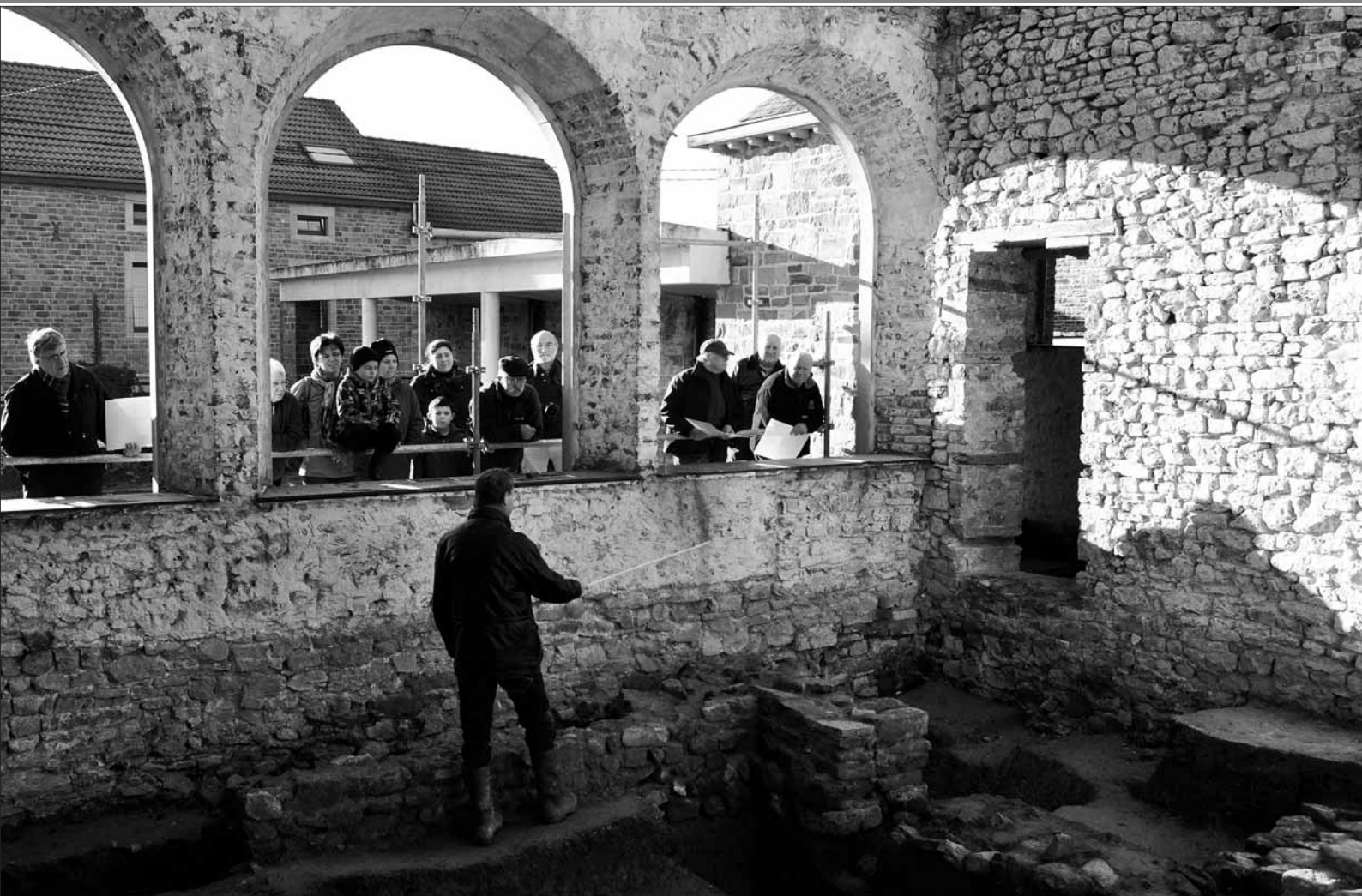
Visite guidée du chantier de l'ancienne église Saint-Martin à Ohey/Jallet.
