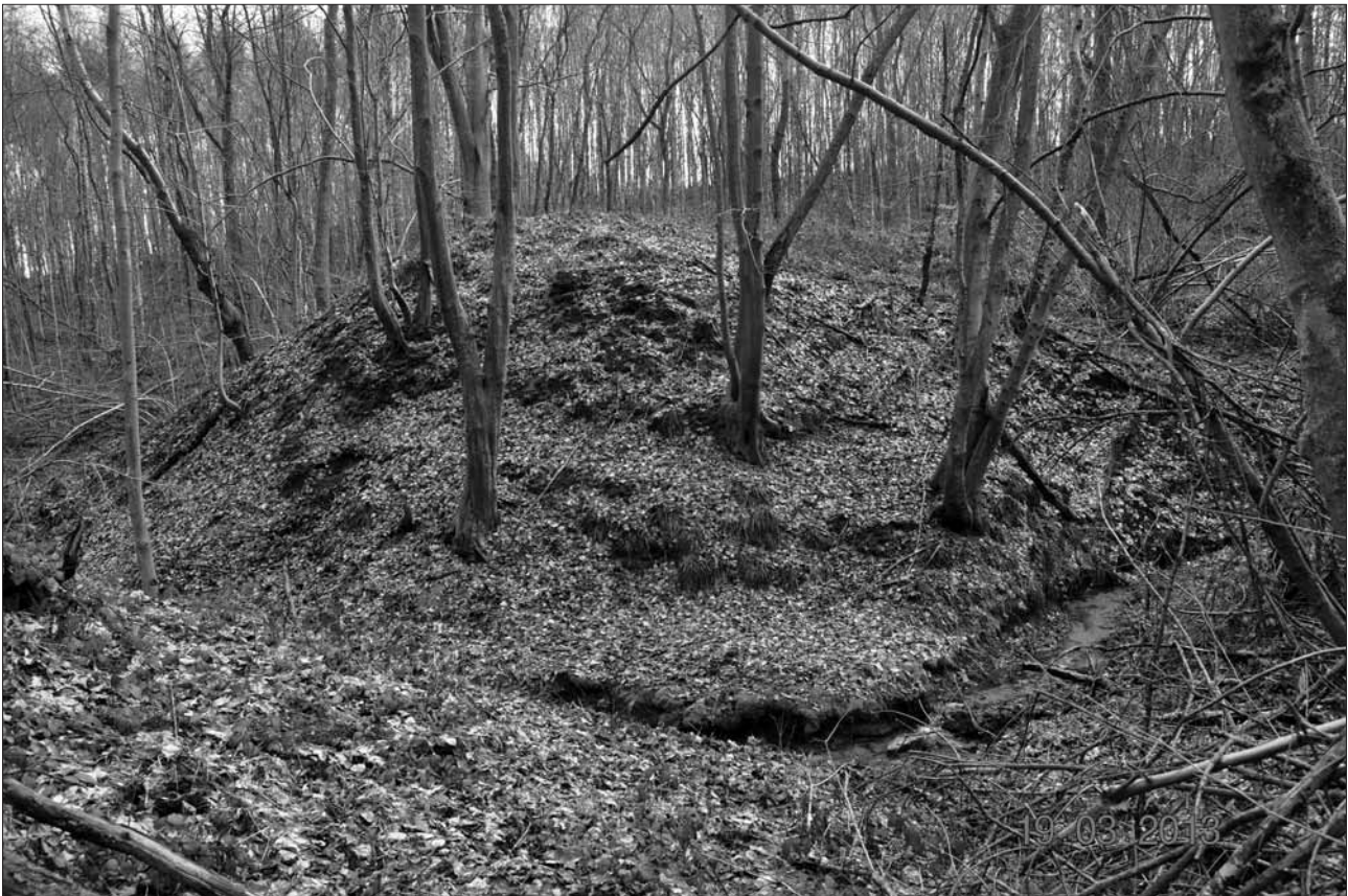
Le barrage de terre du Goddiarch : la trouée médiane dans laquelle coule le ruisseau. Vue depuis l'amont vers le sud.
