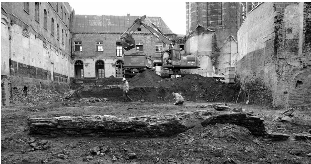
Vue générale du chantier de la rue As Pois.
