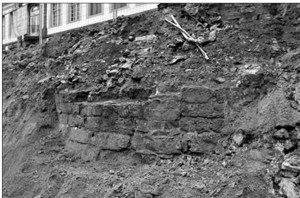
Vestiges de la porte de Marvis dans les talus des terrassements.
