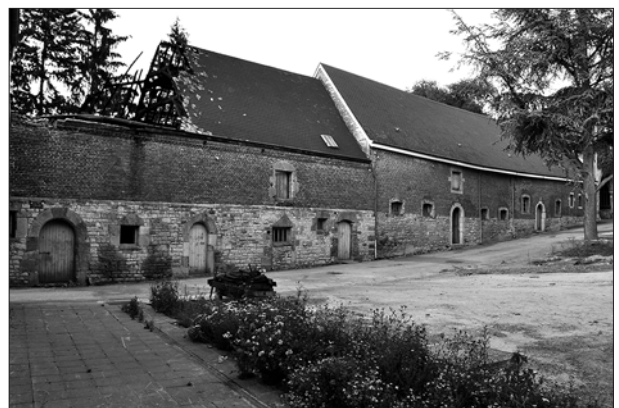
Façades méridionales des bâtiments agricoles de 1480 (zone 14) à droite et de 1539 (zone 7) à gauche.
