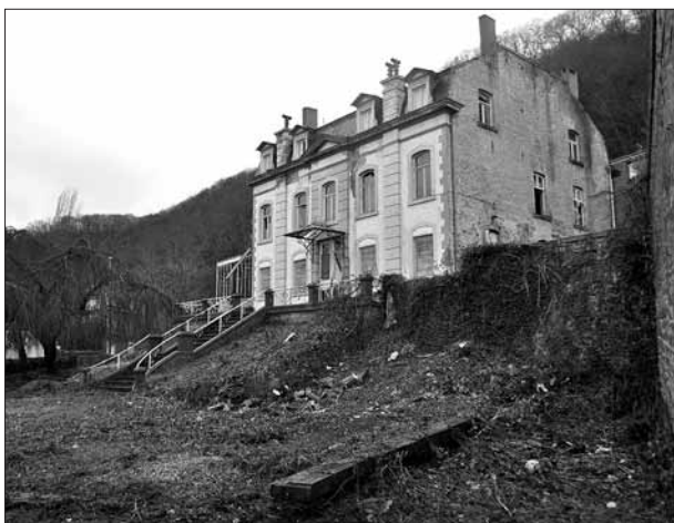
Vue de la maison et des fondations de la serre, vers le sud-ouest.
