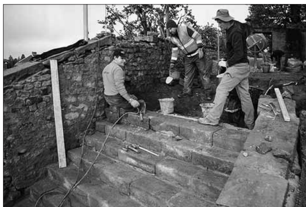
Repose des marches de l'escalier monumental.
