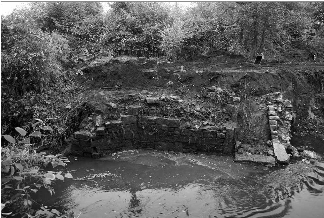
Vue de l'aménagement en berge droite de la Haine à Havré.
