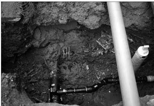
Détail de l'ossuaire traversé par la tranchée destinée à la conduite de gaz.
