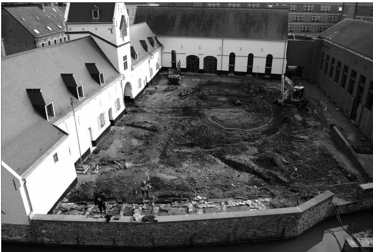
Lessines, cour de la ferme de l'Hôpital Notre-Dame à la Rose. Les vestiges en cours de dégagement.
