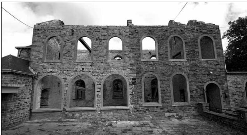
Vue générale du côté sud-est de l'ancienne école. La chapelle occupait le rez-de-chaussée côté gauche.
