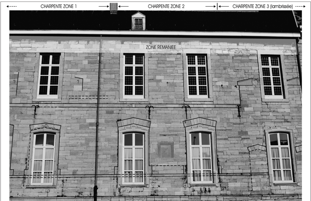
Vue de la façade méridionale du palais épiscopal liégeois avec la mise en évidence de quelques vestiges de baies mitrées ainsi que des cordons qui les cernaient (A. Mélon, Serv. archéologie, Dir. ext. Liège I).
