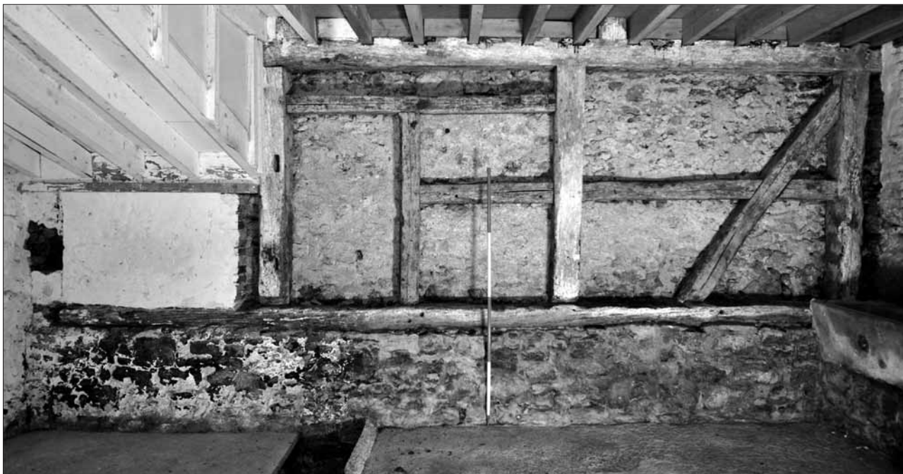
Détail d'un pan-de-bois dégagé dans le bâtiment agricole de 1480 (zone 14).
