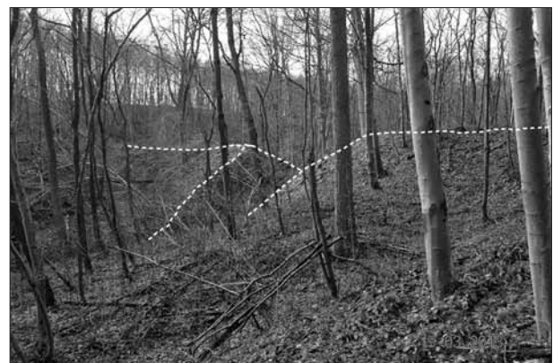
Le barrage de terre barrant le vallon du Goddiarch. Vue depuis l'aval vers le sud.
