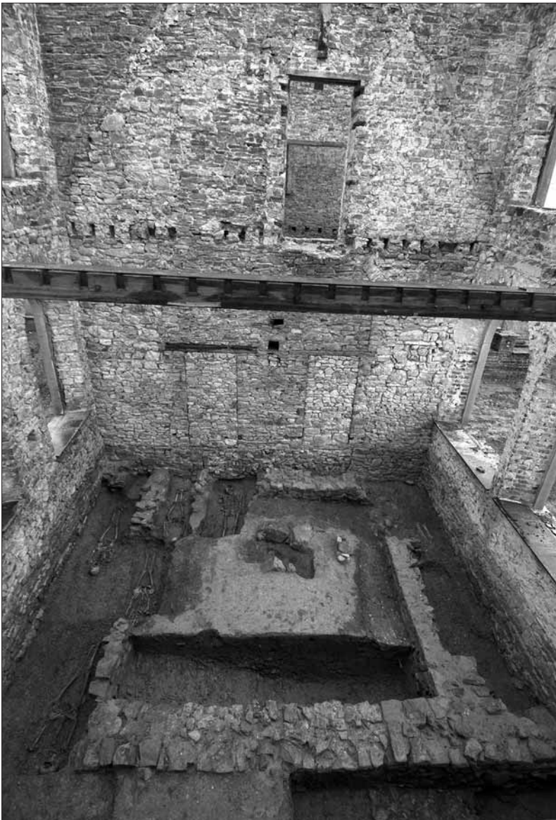
Vue générale vers le nord-est des vestiges des deuxième et troisième phases mis au jour dans l'emprise de la chapelle.
